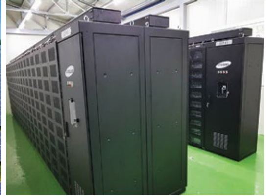
ESS 10 MW/20MWh
